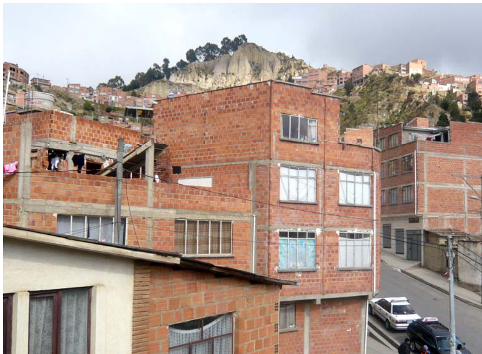
Wohnhäuser in fertigem Zustand
